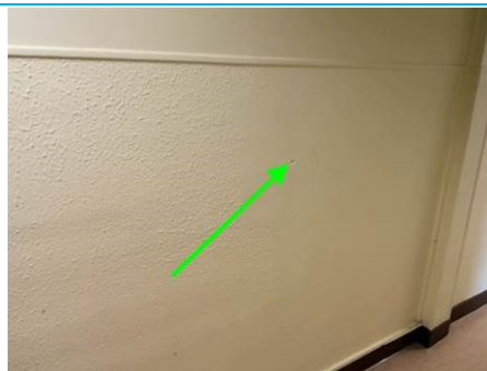
Matériaux : ZPSO-006 Prélèvement : P007 Description : Enduits à base de plâtre ou ciment projetés, lissés ou talochés+Peinture à goutte Localisation : 3ème étage Aile C - Couloir 1 Résultat : Absence d'amiante
