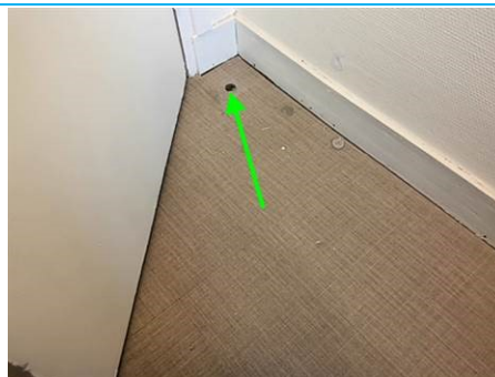
Matériaux : ZPSO-028 Prélèvement : P041 Description : Ragrage+Chappe Localisation : 3ème étage Aile C - Rgt Résultat : Absence d'amiante
