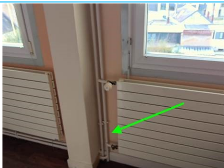
Matériaux : ZPSO-024 Prélèvement : P032 Description : Enduit à base de plâtre lissé ou taloché+revêtement mural Localisation : 3ème étage Aile C - Serveur Résultat : Absence d'amiante
