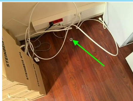
Matériaux : ZPSO-023 Prélèvement : P030; P031 Description : Ragréage+Chappe Localisation : 3ème étage Aile C - Serveur; 3ème étage Aile C - Bureau 324 Résultat : Absence d'amiante
