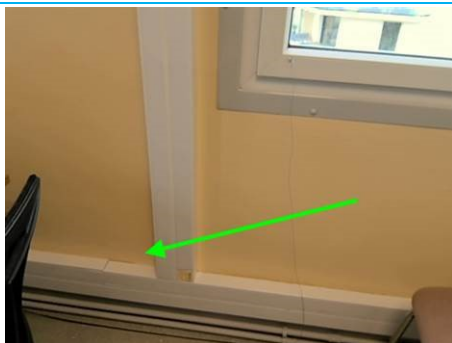
Matériaux : ZPSO-012 Prélèvement : P015 Description : Enduit à base de plâtre lissé ou taloché+toile de verre peinte Localisation : 3ème étage Aile C - Bureau 325 Résultat : Absence d'amiante
