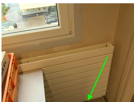
Matériaux : ZPSO-003 Prélèvement : P010 Description : Enduit à base de plâtre lissé ou taloché+Peinture Localisation : 3ème étage Aile C - Archive 327 Résultat : Absence d'amiante
