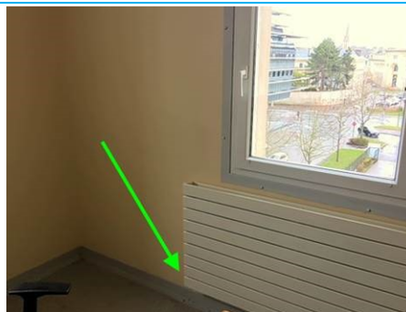
Matériaux : ZPSO-012 Prélèvement : P018 Description : Enduit à base de plâtre lissé ou taloché+toile de verre peinte Localisation : 3ème étage Aile C - Bureau 326 Résultat : Absence d'amiante
